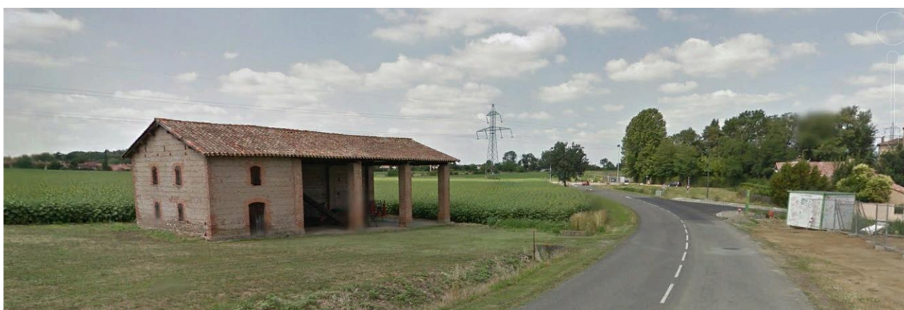
Le bâtiment agricole existant présentant un intérêt patrimonial à conserver
