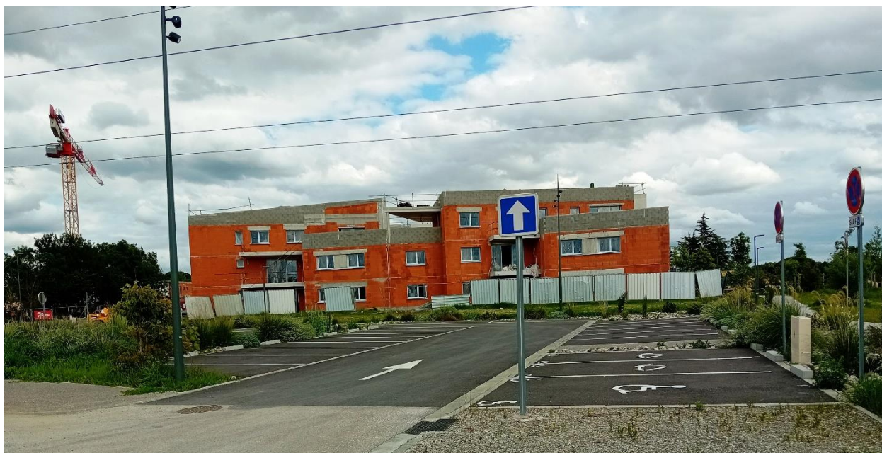
Parking en enrobé sur Argento 2 :
