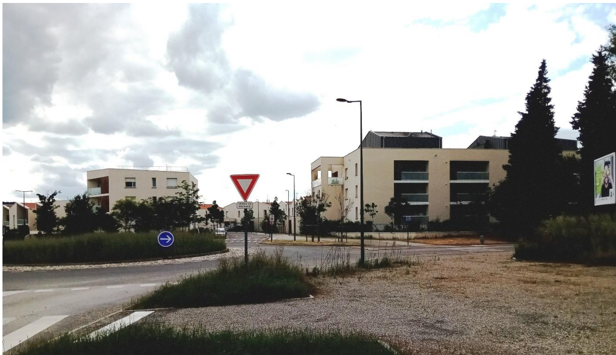
Immeuble R+3 Sur Argento 1 :
