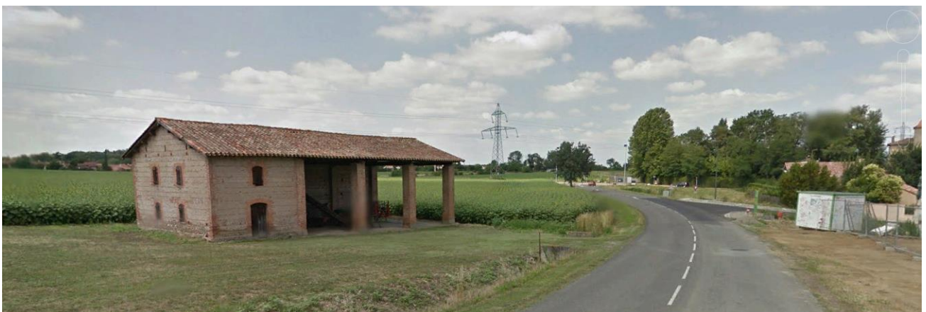
Le bâtiment agricole existant présentant un intérêt patrimonial à conserver
