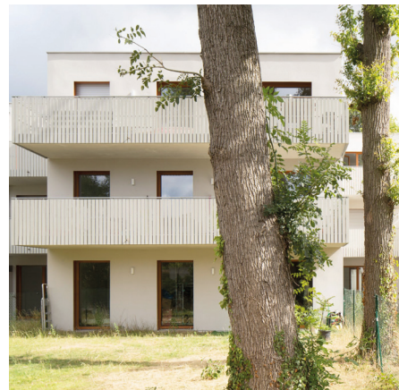
Des circulations extérieures en lames de bois peintes Réf. Majma architecte
